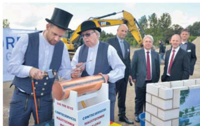
Der Grundstein für das neue Bürocenter ist gelegt. Im Hintergrund: Bezirksamtsleiter Thomas Völsch und die Baubeteiligten
