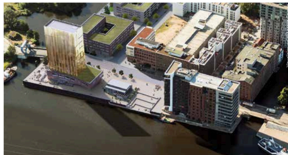
Das 4-Sterne-Hotel am Veritaskai – im Mai soll voraussichtlich mit dem Bau begonnen werden.
