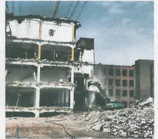
Bagger marsch: So sah es vor wenigen Wochen an der Seehafenstraße in Harburg aus. Hier wird eine Fläche für die Ansiedlung einer Spedition und der Firma Mateco vorbereitet. Foto: Wolfgang Becker
