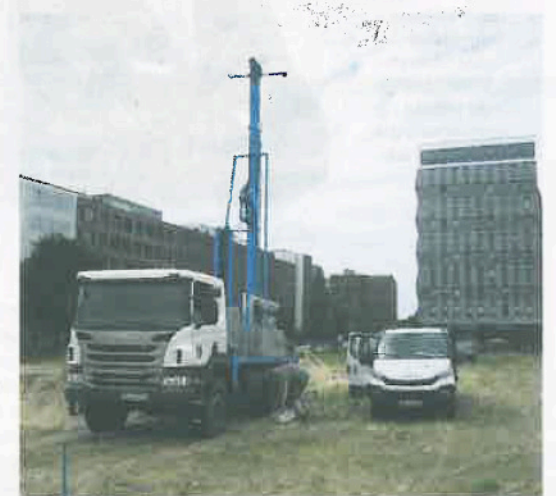
Auf der ehemaligen Beachclub-Fläche am Veritaskai ist ein Bohrerät zur Untergrundanalyse in Stellung gebracht worden. Hier soll das Hotel gebaut werden.
